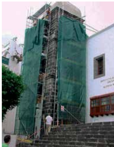
Imágenes de los trabajos de restauración de la Torre de la Iglesia de Santo Domingo (S. XVIII), La Palma.
