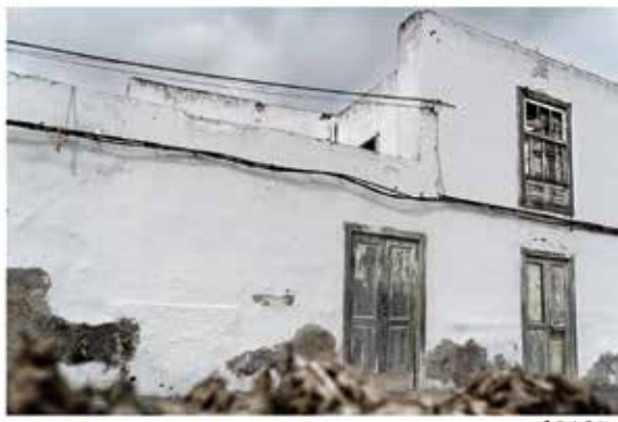
Exterior de una de las antiguas tiendas de aceite y vinagre.
